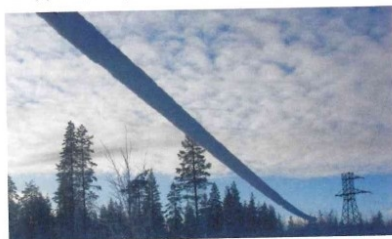
Рис. 1. ГИО на фазных проводах наблюдаемой линии
